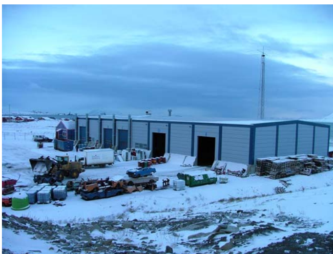
Avfallsanlegget i Longyearbyen. Oktober 2004
