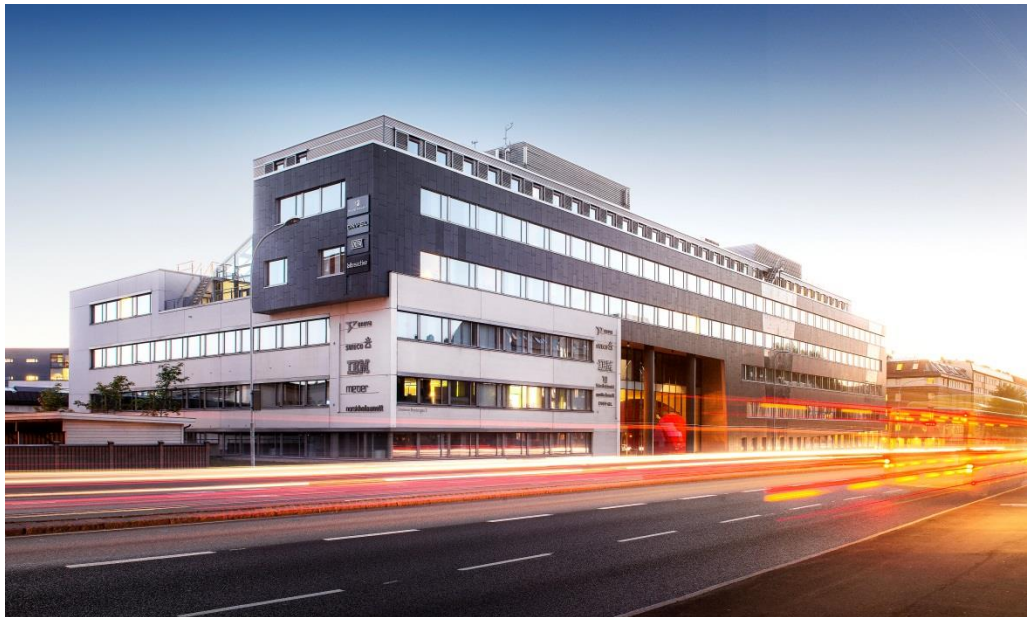
KLPs Miljøbygg i Trondheim, hvor Enova er leietaker
