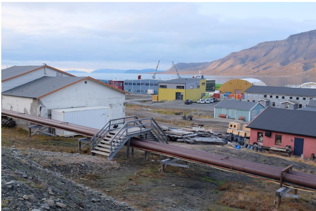
Området sett fra sørøst. Hjørnet av Gamle potelageret ligger til venstre, og gangveg med bro over rørgaten ligger i front av bildet. Maler Anderssen ligger i gult/grått bygg midt i bildet.
